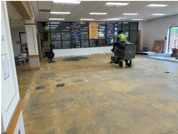
CES - Media Center demolition
